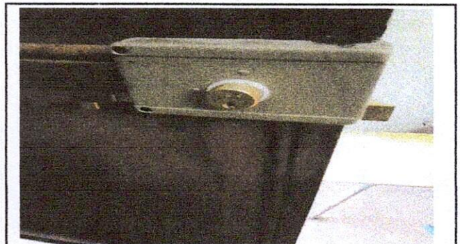
Foto 4: Cambio de chapas de las puertas del primer módulo
